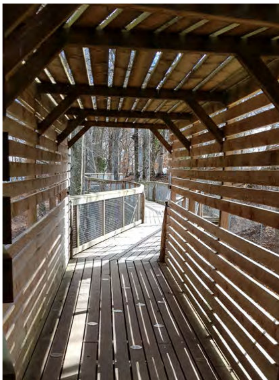
Passerelle à la Garenne labellisée « Bois suisse ».
