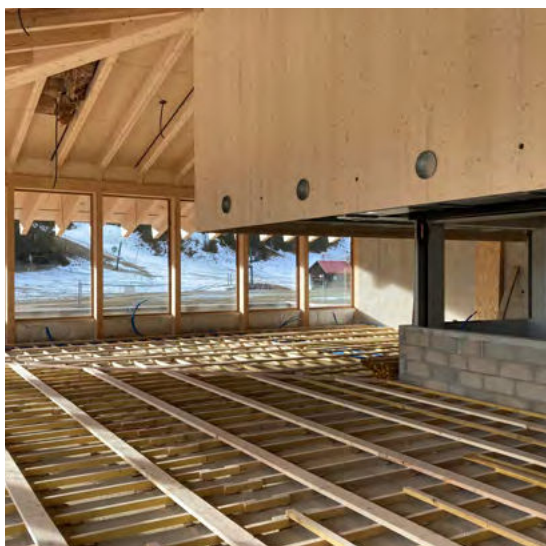
Les travaux du bâtiment d'accueil des Dappes sont retardés.
