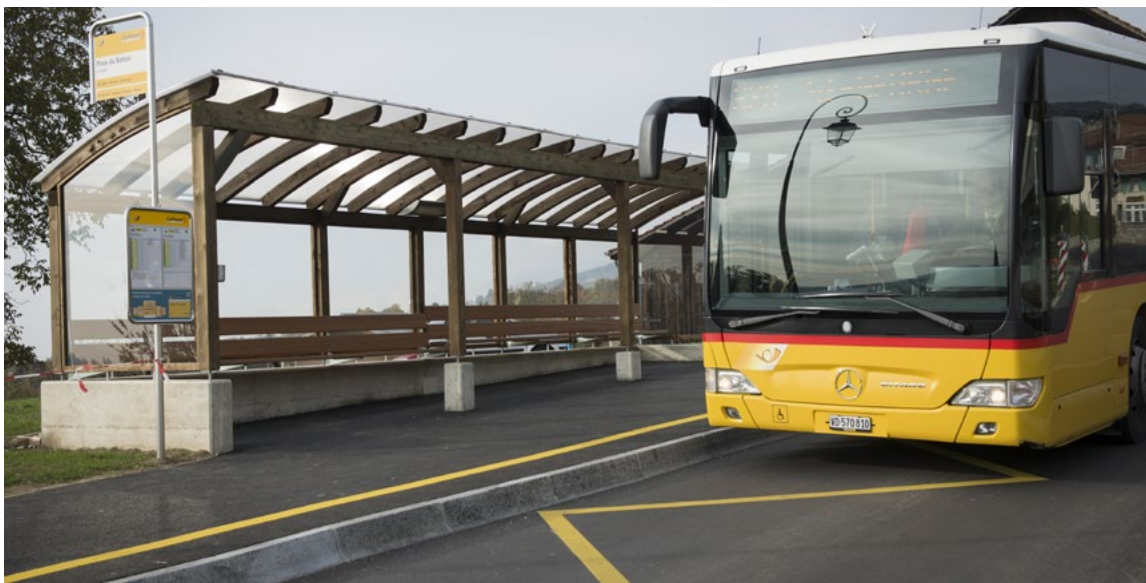
Arrêt de bus «Place du Battoir», à Le Vaud, entièrement réaménagé en 2015 avec réfection du revêtement et pose d'un abribus en bois suisse. Ce chantier a permis la pose d'une bordure d'accostage haute réduisant la distance entre le plancher du bus et le trottoir.
