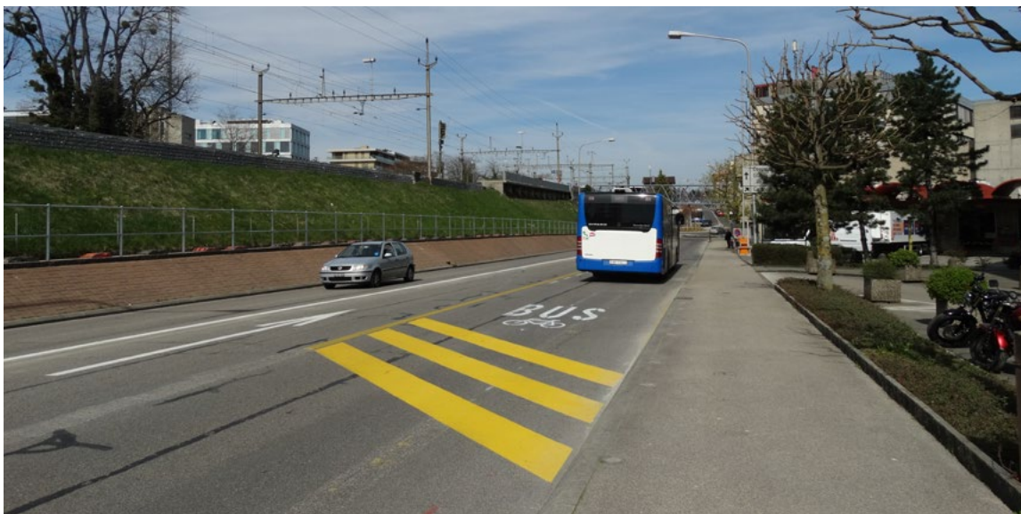
Voie de bus réalisée à Nyon en 2014, permettant de tenir les horaires des transports publics aussi aux heures de pointe.
