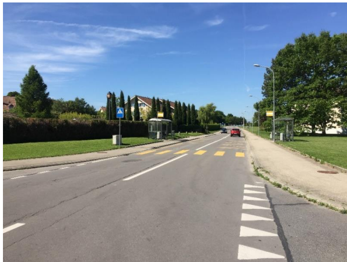
Photo 5 : Carrefour Vignerons – Rue de la Poste – Rue de la Gare
