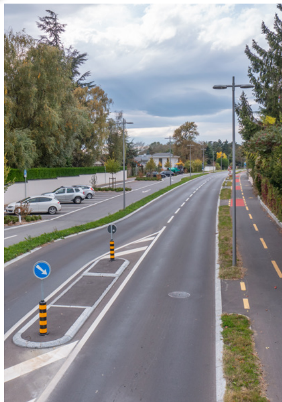
Le réaménagement de la Route Suisse entre Coppet et Perroy se fait par étapes et permet d'améliorer la sécurité des cyclistes.
