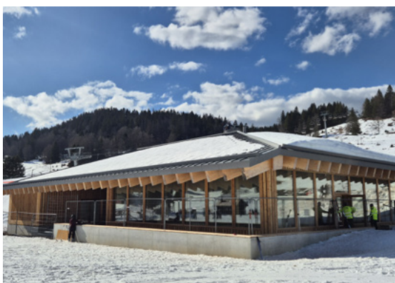
Le chantier du bâtiment d'accueil le Lapin Blanc aux Dappes a pu reprendre en 2025.
