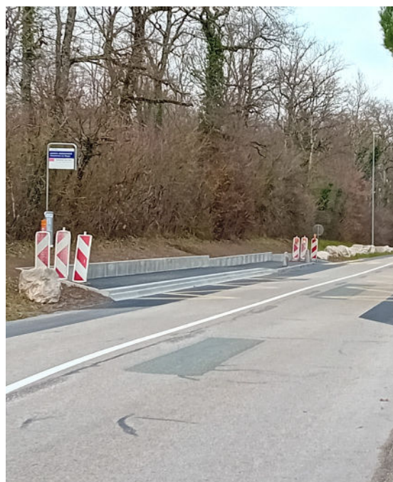
Aménagement d'un nouvel arrêt de bus au centre commercial de Chavannes-de-Bogis.
