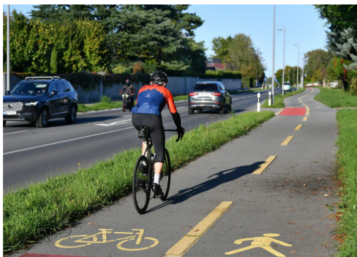
Aménagement voies cyclables et piétons entre Coppet et Nyon.
