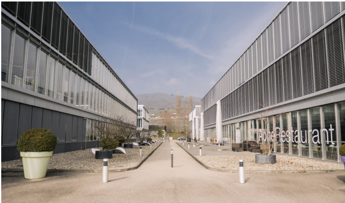
Site d'entreprise A-One à Rolle
