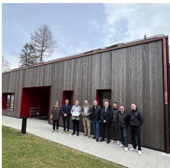
Inauguration du nouveau bâtiment de l'UAPE à Gimel, labellisé Bois Suisse, en présence des autorités et partenaires du projet.
