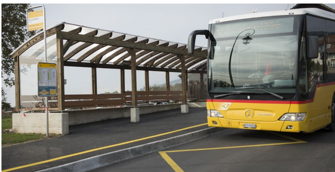
Arrêt de bus «Place du Battoir», à Le Vaud, entièrement réaménagé en 2015 avec réfection du revêtement et pose d'un abribus en bois suisse. Ce chantier a permis la pose d'une bordure d'accostage haute réduisant la distance entre le plancher du bus et le trottoir.
