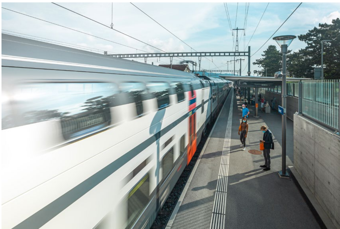
Les passagers rejoignant le train à Gland ont bénéficié d'améliorations sur les arrêts de bus situés au sud des voies.
