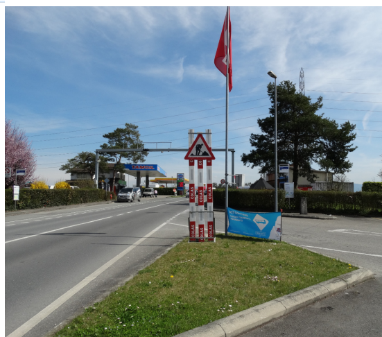
Figure 41 : Communication chantier – Jonction de Coppet
