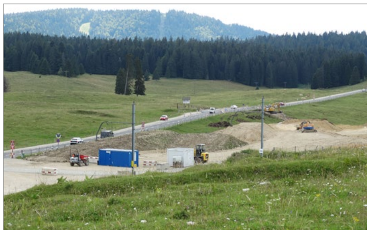
Comblement du vallon de la Givrine, en 2018, pour accueillir les aménagements.
